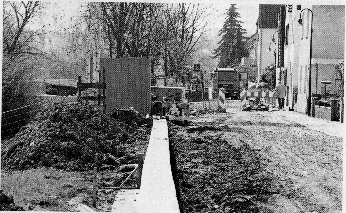
In zirka vier Wochen sollen die Erdarbeiten in der Rheinstraße abgeschlossen sein.
